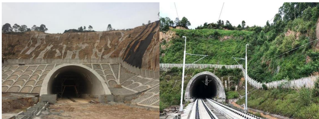
广清城际银盏 1 号隧道石质边仰坡绿化前后对比照片
