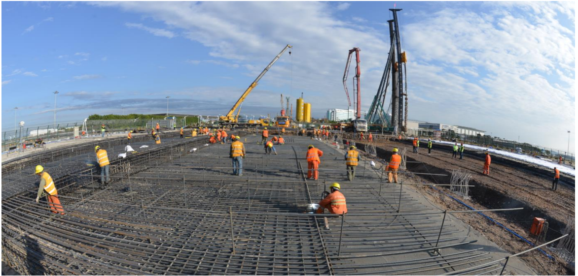
天贵站施工现场
