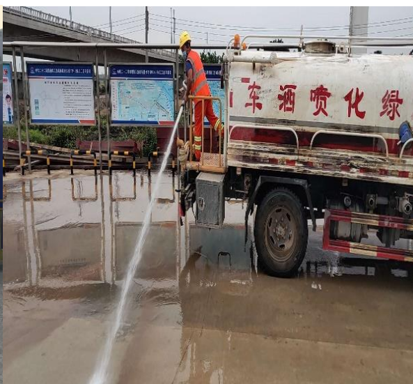
施工场地日常清理
