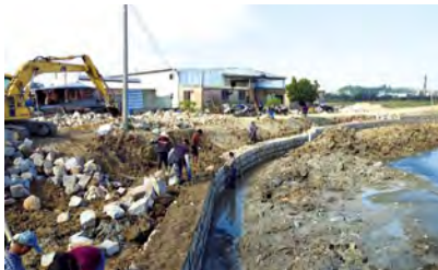
西塘村池塘石护坡石护栏项目施工现场
